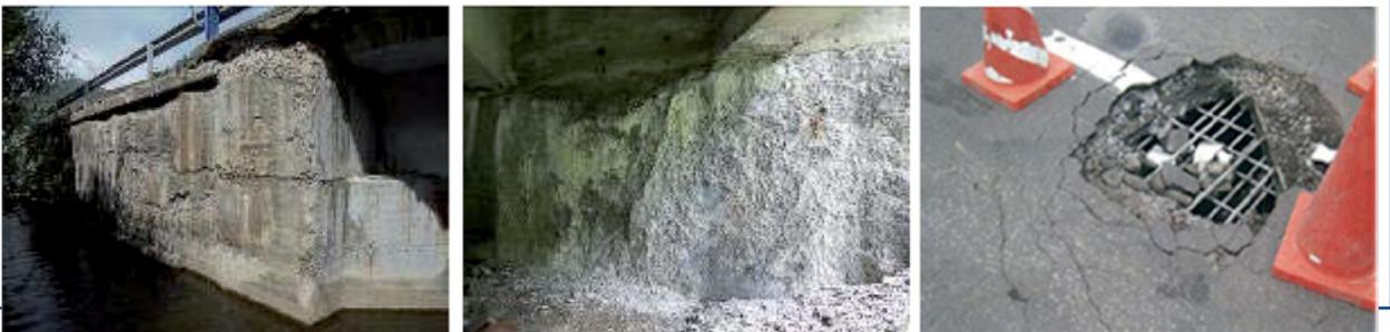
Illustration 15 (thème 8) - Des dégâts à la butée, à la paroi et à la surface à cause des cycles gel/dégel
