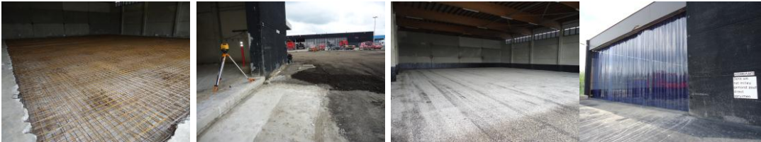
Figure 5 : reconstruction d'un entrepôt après décontamination. Le sol de l'entrepôt est supprimé et remplacé par un dallage étanche, le terrain autour de l'entrepôt est également restructuré, un revêtement protecteur est appliqué aux parois internes de l'entrepôt, et des procédures de meilleures pratiques sont adoptées.
