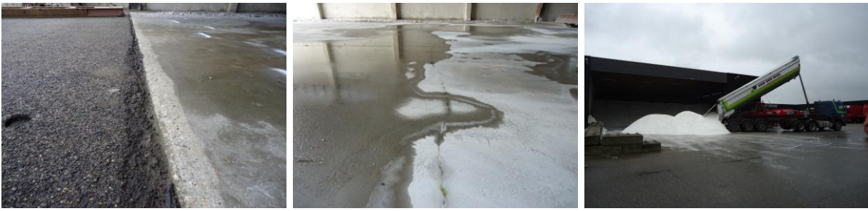
Figure 3 : stockage du sel en intérieur et situations où l'eau et la saumure peuvent pénétrer dans le sol
