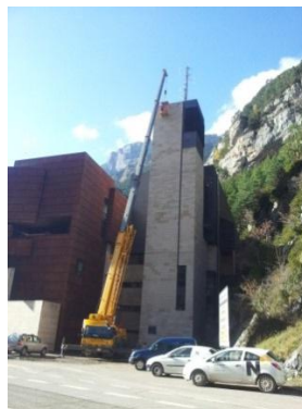
Figura 17.- Reparación de enlosado de un edificio de control tras temporal de viento
