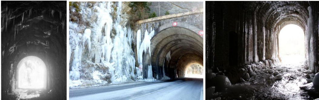
Figura 8.- Diferentes entradas a un túnel con estalactitas
