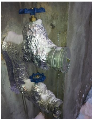
Figura 14.- Detalle de protección contra congelación de boquerel
