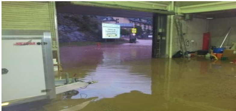
Figura 16.- Inundación de garaje de vehículos de intervención tras fuerte tormenta
