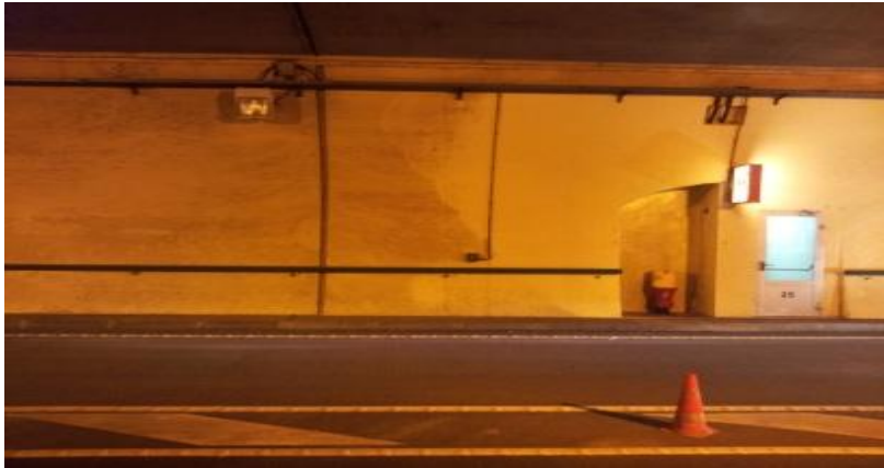
Figura 11.- Efecto de la iluminación: izquierda sin limpiar; derecha tras la limpieza
