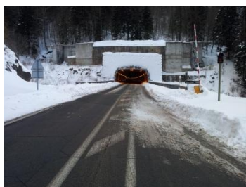
Figura 15.- Marca vial degradada por el uso de los quitanieves
