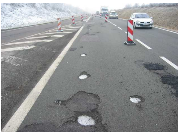
Figure 1. Chapelets de nids de poule apparus en quelques heures
