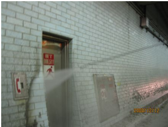
(a) Nettoyage de la signalisation
