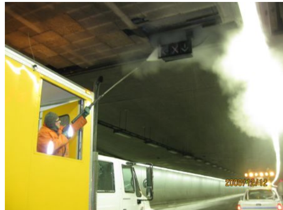
(b) Nettoyage des feux de voies
