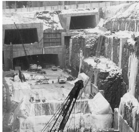
(b) Tranchée au tunnel Ville-Marie
