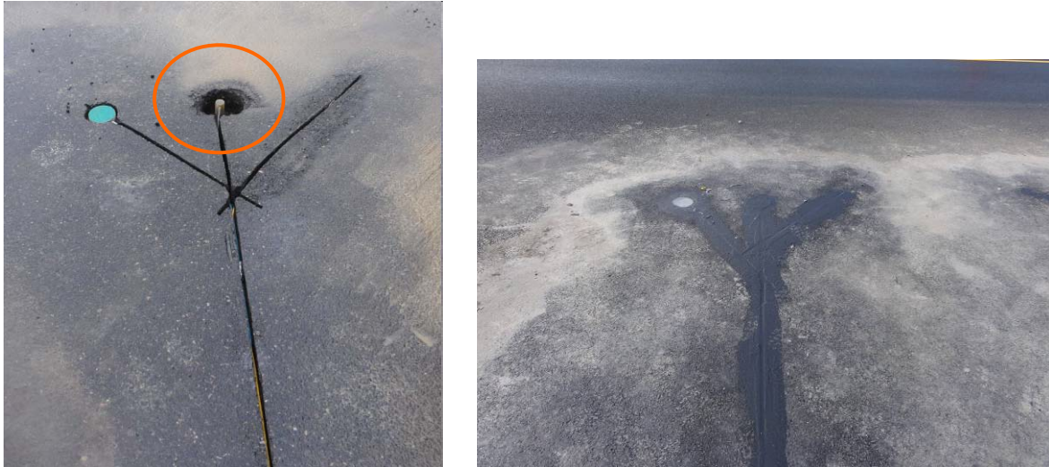
Figure 7 - Installation du tube de gel dans la chaussée
