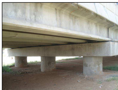
Figura 5 Puentes tipo D
