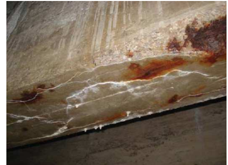
Figura 8 Estructura n°2; N-630, p.k 88
