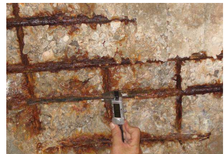
Figura 9 Estructura n°2; N-630, p.k 88
