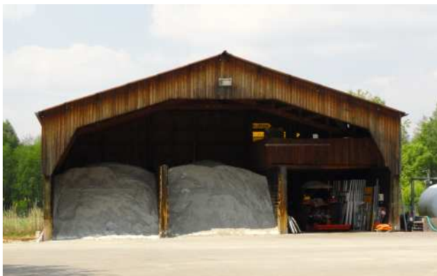
Photo 1 - Abri bois avec double travées
