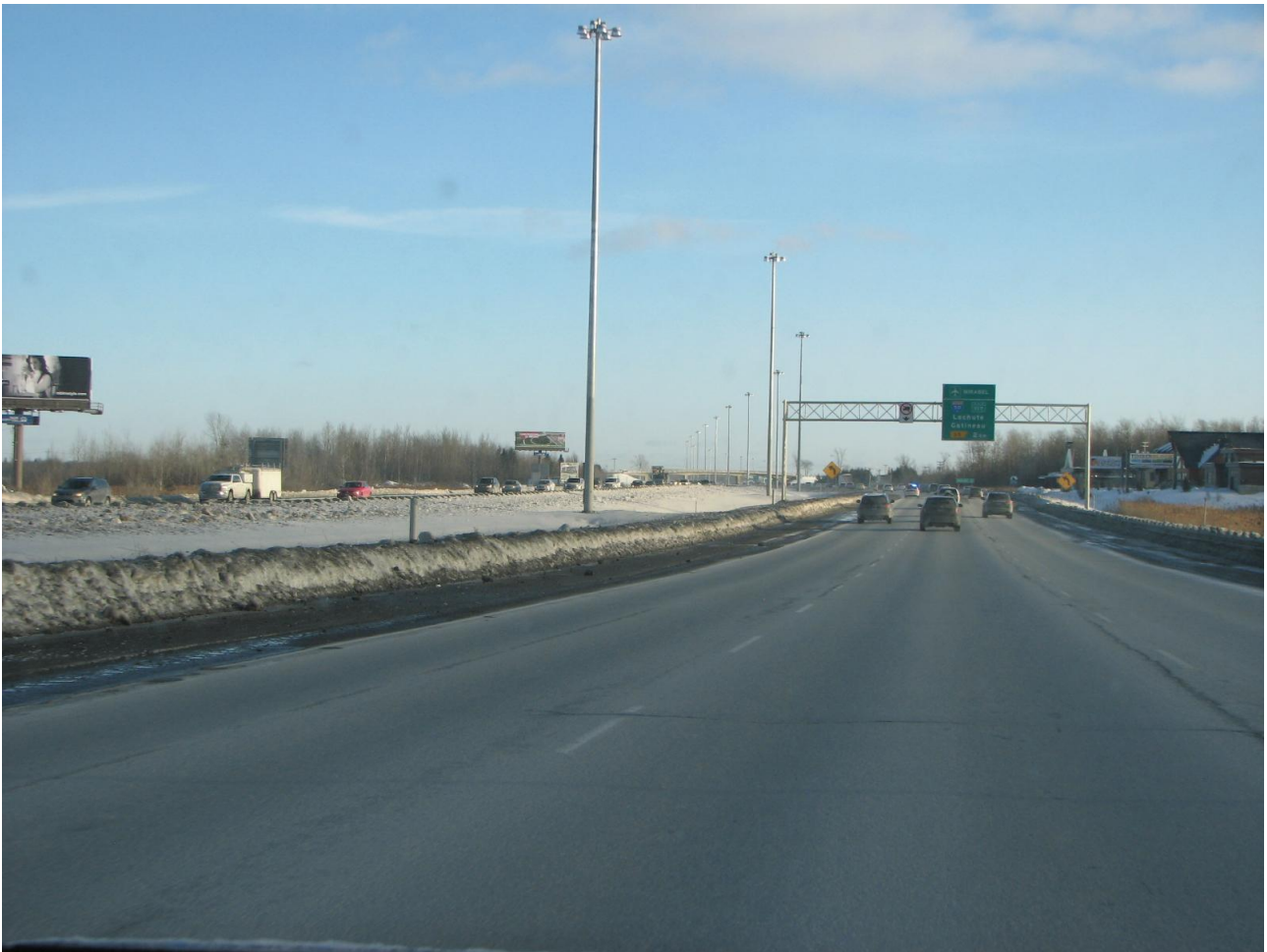
Figure 6 – Perte de la zone de récupération
