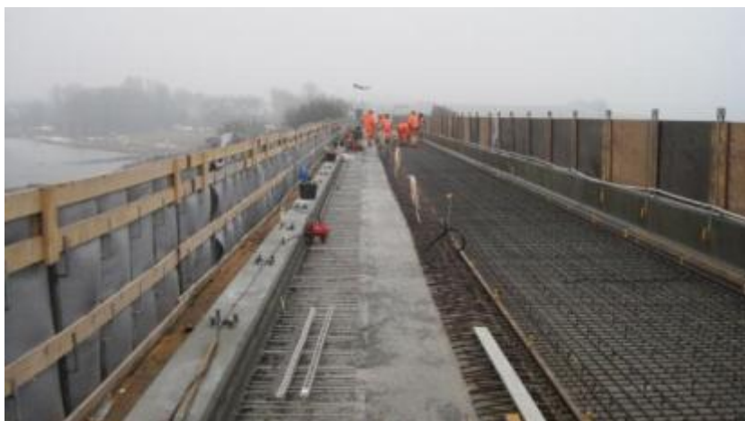
Fig. 8. Tablier de pont avec renforcement de la couche de béton
