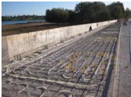
Fig. 16. Tuyaux d'eau chaude du tablier.
