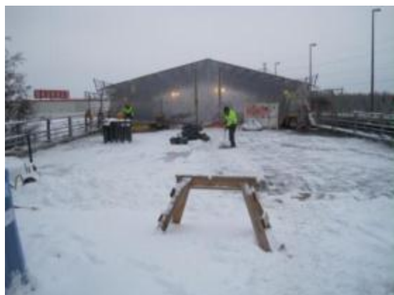
Fig. 15. Abri de chantier installé sur un pont semblable
