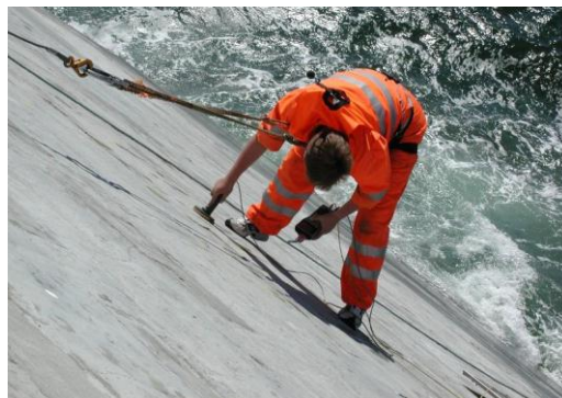
Fig. 4. Essai non destructif réalisé à l'aide du système s'MASH
