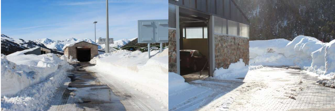
Fotografías 8 y 9. Detalles de las dependencias y garajes para la maquinaria.
