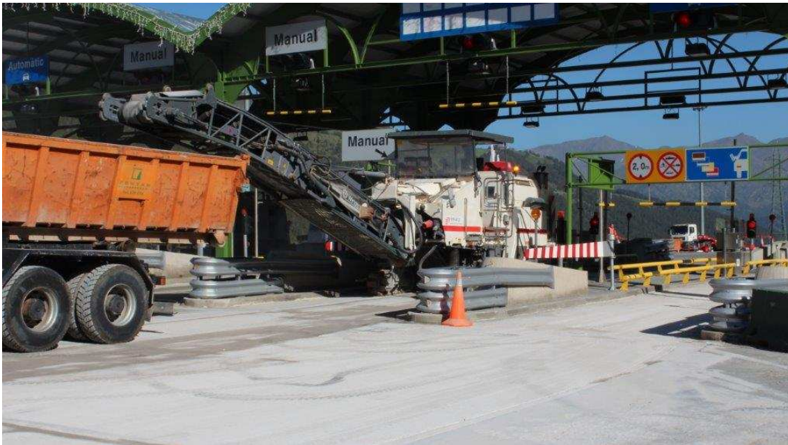
Fotografía 5. Ejecución de un micro fresado de la superficie de hormigón en verano de 2012.
