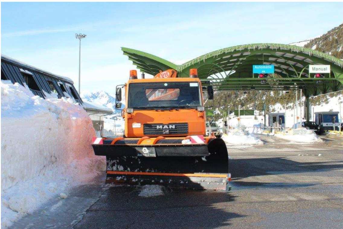
Fotografía 19. Acumulación de nieve frente al edificio de control en febrero de 2013.
