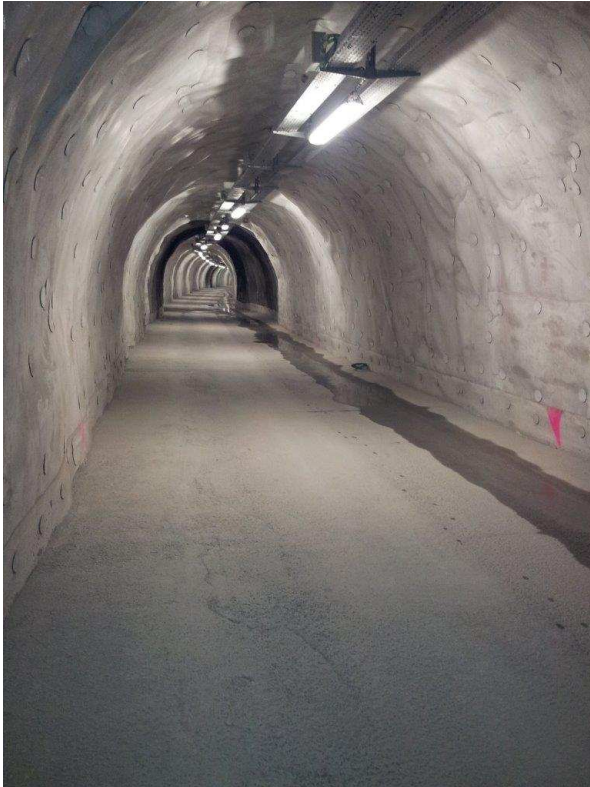
Fotografía 4. Interior de la galería de evacuación.
