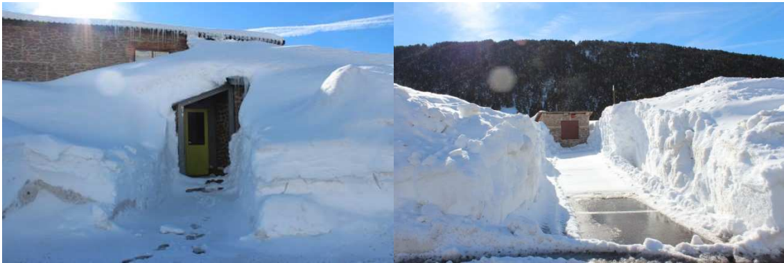
Fotografías 14 y 15. Detalles del acondicionamiento de los accesos a las instalaciones.
