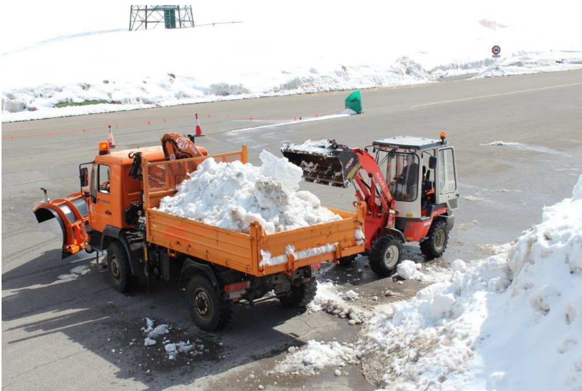
Fotografía 21. Operación de carga y transporte de nieve, en febrero de 2013.
