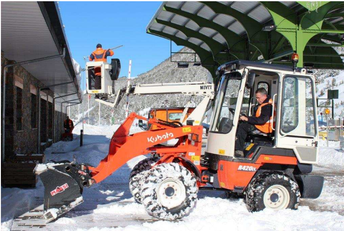
Fotografía 17. Detalle de la retirada de la nieve en el entorno del edificio del centro de control.
