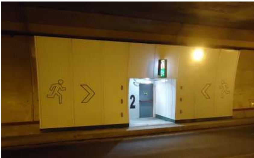
Fotografía 3. Acceso número 2 a la galería de evacuación.
