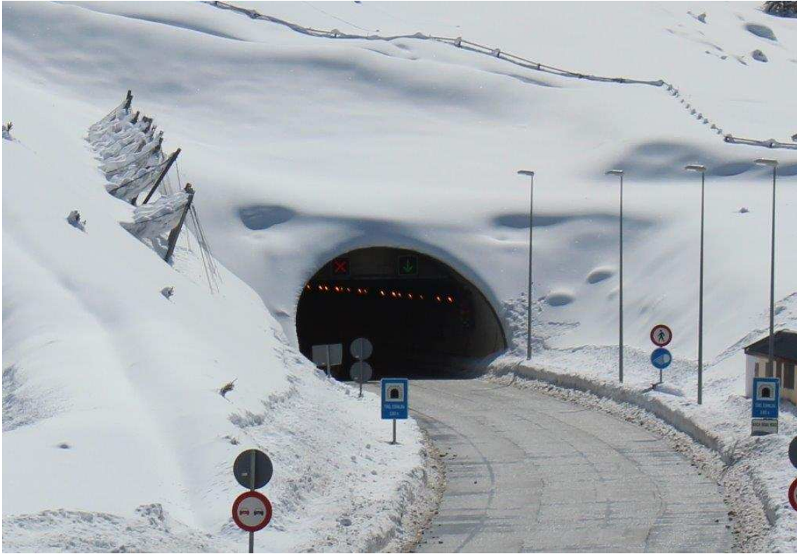
Fotografía 18. Detalle de la acumulación de nieve en las bocas, antes de su limpieza.
