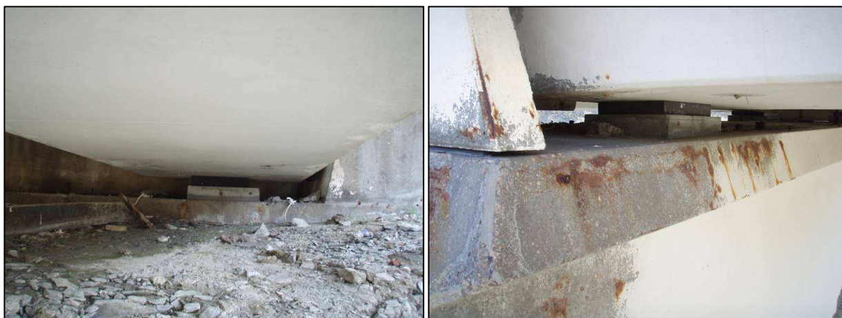
Figuras nº 5 y nº 6. Apoyo de viga izquierda en estribo nº 1 (izquierda) y de viga derecha en pila nº 2 (derecha)
