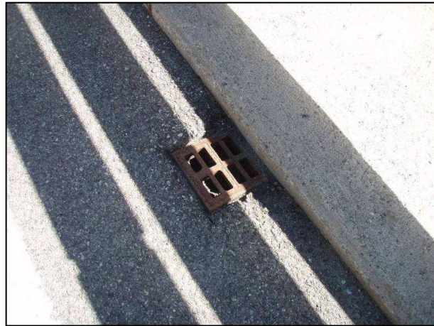
Figuras n° 8 y n° 9. Tubo de desagüe en vano n° 4 (izquierda) y rejilla de protección del sumidero en vano n° 2 (derecha)
