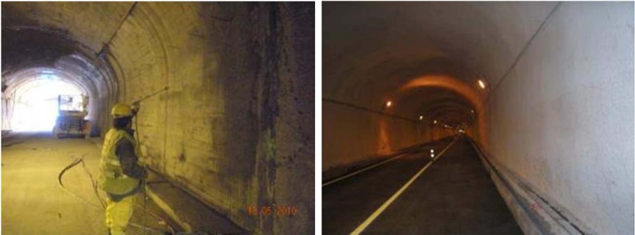
“Fotografía 11 - Aplicación de la lámina impermeabilizante”
