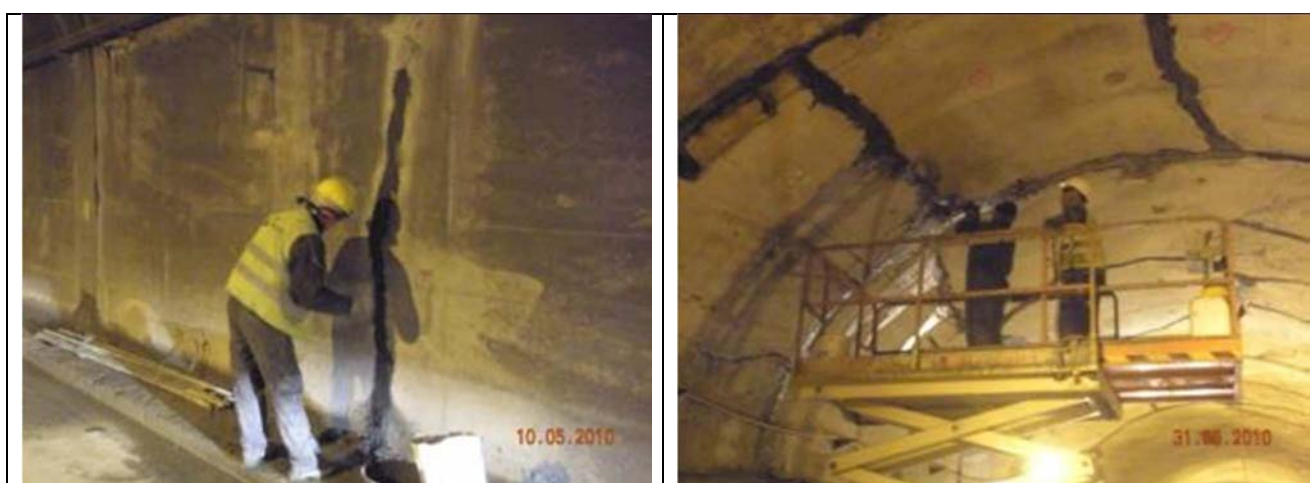
“Fotografía 10 - Tratamiento de filtraciones”
