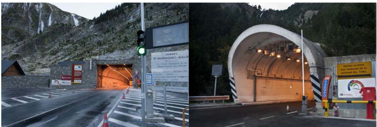
“Fotografía 1 - Boca Norte y Boca Sur del Túnel de Bielsa – Aragnouet.”
