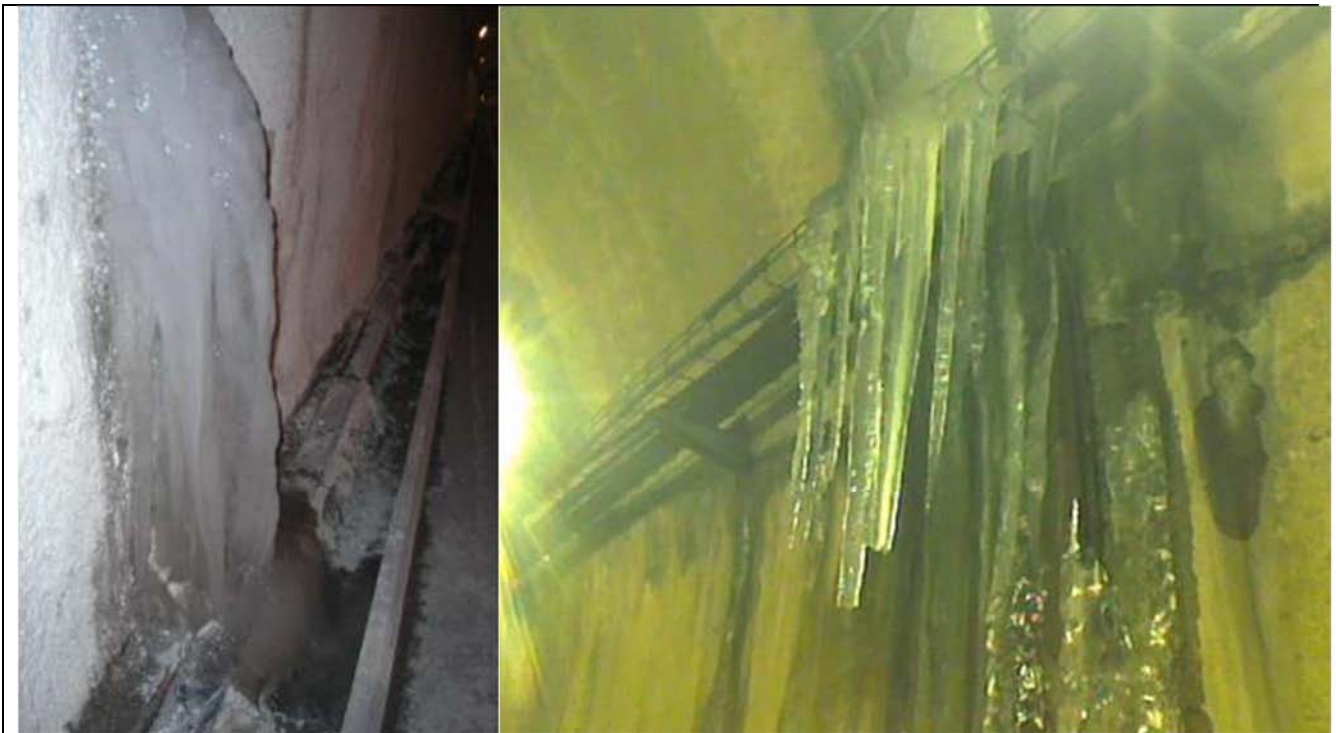
“Fotografías 5, 6 - Formaciones de hielo en el paramento en el Túnel de Bielsa – Aragnouet”
